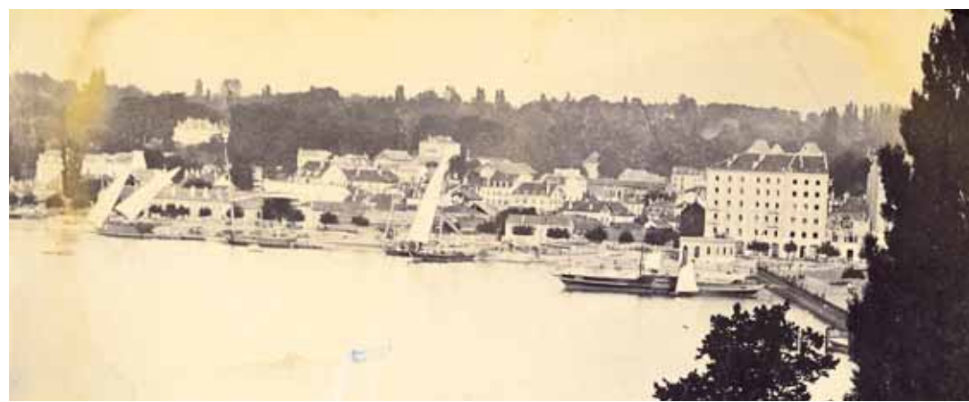
Le port et le quai des Eaux-Vives en construction, en 1863. Photographie anonyme, prise depuis la place des Bergues. De droite à gauche, un peuplier de l'Île Rousseau, les immeubles du square des Eaux-Vives, l'ancienne douane du port de Longemalle, avec, à l'arrière, la tour de la dernière calandre de la fabrique d'indiennes Musy, la rangée des premiers platanes, les constructions basses et les hangars. Les domaines des Vollandes et de Montchoisy émergent des frondaisons.
